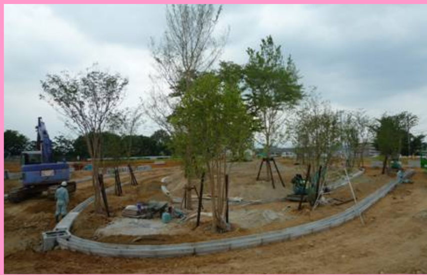
造成中の実証用分譲住宅（市内東山地区）
